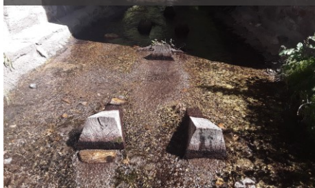
Aménagement d'un radier pour créer des zones de repos lors de la montaison EYN-1
